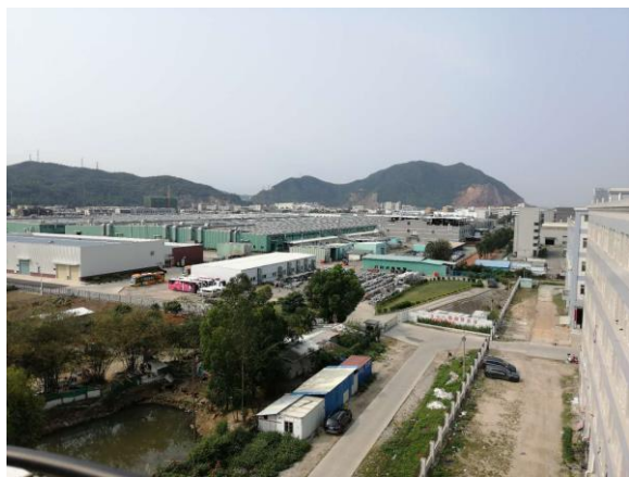
项目西面银隆新能源
